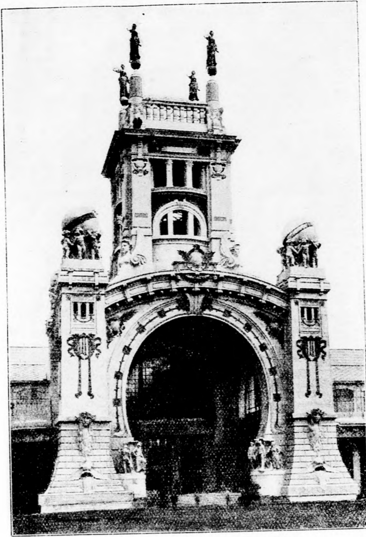
Eingangstor der großen Ausstellungshalle.
