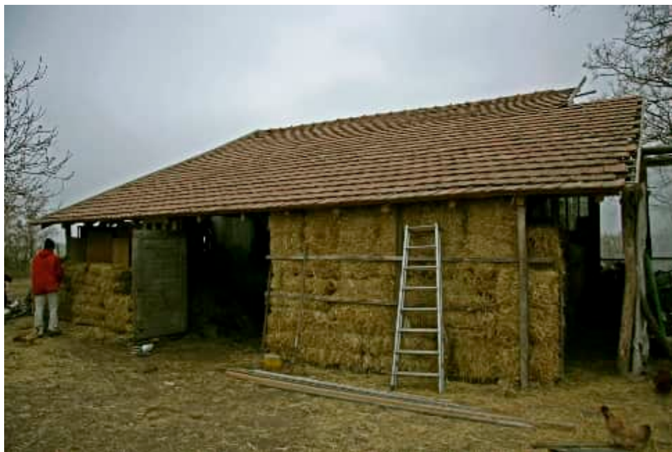
Istálló szalmabála hőszigetelése. 2011, Gátér. Fotó: Holczer Veronika
