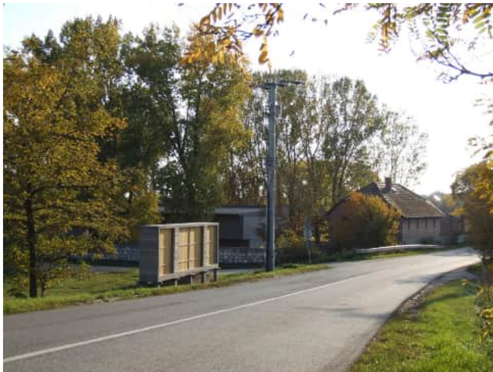
Elkészült vasbeton szerkezetű kukoricagóré. 2013, Perbál. Fotó: Kemes Balázs
