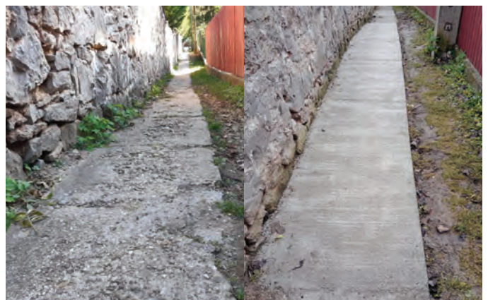
A Kastély-köz burkolatának felújítása, 2021 ősz vége.
