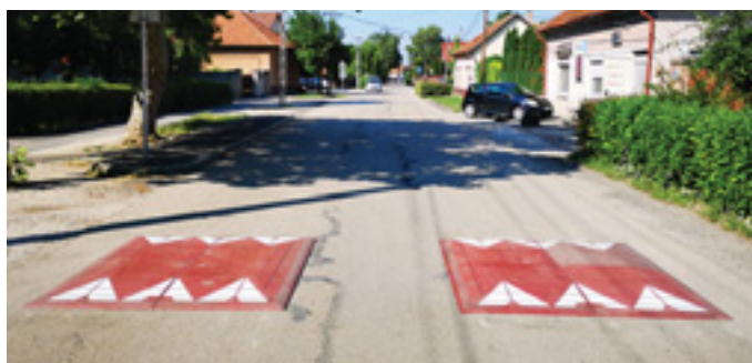
Üllőn, az általános iskola előtt telepített sebességcsillapító párnák
