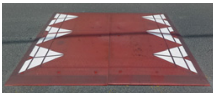
Sebességcsillapító párna kialakítása
