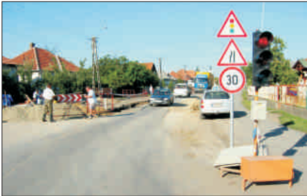
Lámpázott város – Épül a csatornahálózat (Fotó: Nagy Mária)
