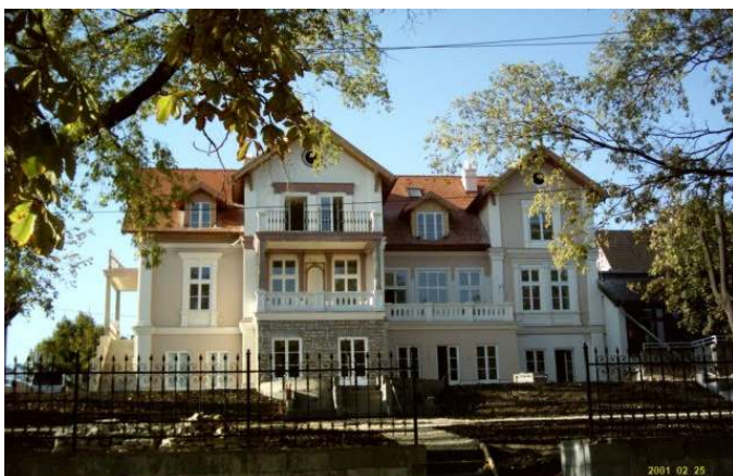
A balatonfüredi Eszterházy-villa, melynek eredeti állapotba való visszaállítását mi végeztük
