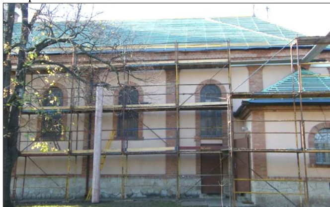
A tetőfelújítás 2013-ban
