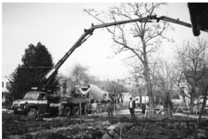
Épül a konyha: így kezdődött 02.26.
