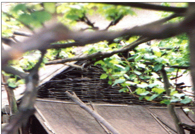
3. kép. Gazdasági építmény tűzfalának vízszintes sövényfonata (A szerző felvétele)
