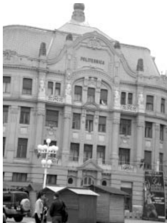
A Temesvári Politechnika Ház épülete
