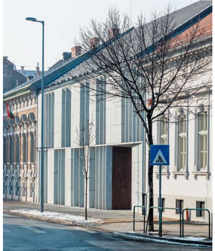
KŐBÁNYAI ÜGYFÉLSZOLGÁLATI KÖZPONT. ÉPÍTÉSZEK: LUKÁCS ISTVÁN, VIKÁR ANDRÁS, GÁL ÁRPÁD FOTÓ: BUJNOVSZKY TAMÁS
