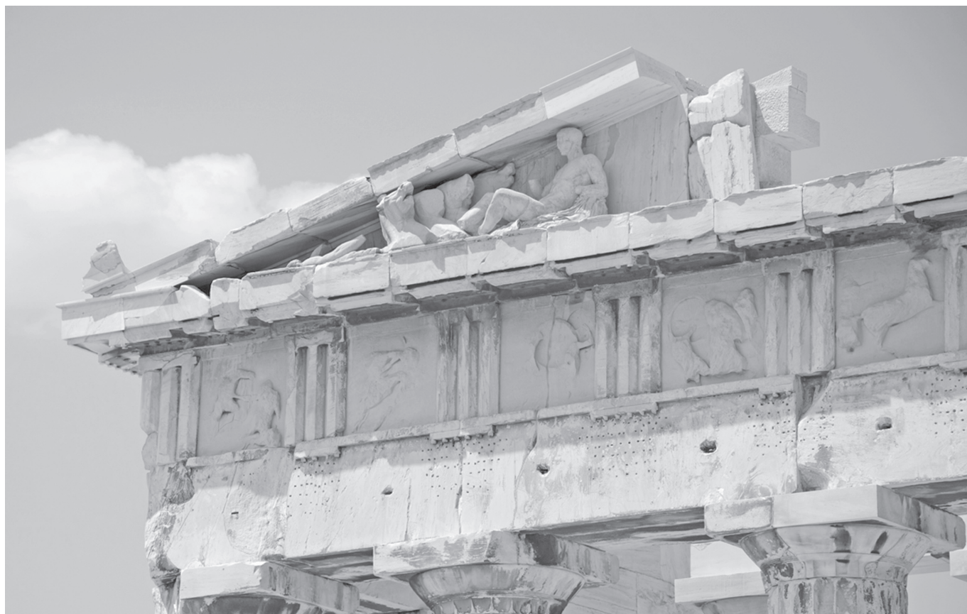
1 kép. A Parthenón keleti homlokzatának részlete az architrávon megmaradt pajzslenyomatokkal és a közöttük lévő feliratok bronzbetűinek csaplyukaival
