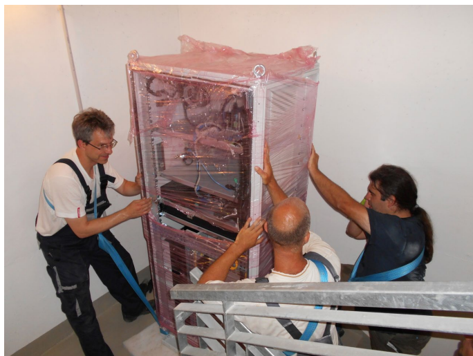
1. ábra: A szentesi radar telepítése (2014. június). Az OMSZ szakemberei a radarszekerényt a lépcsőházon keresztül a 9. emeleten található radarszobába szállítják.
