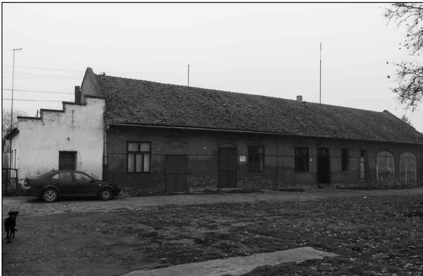
Bácsföldvár – a községháza udvarában, ebben az épületben, az egykori istállóban tartották fogva az áldozatokat
