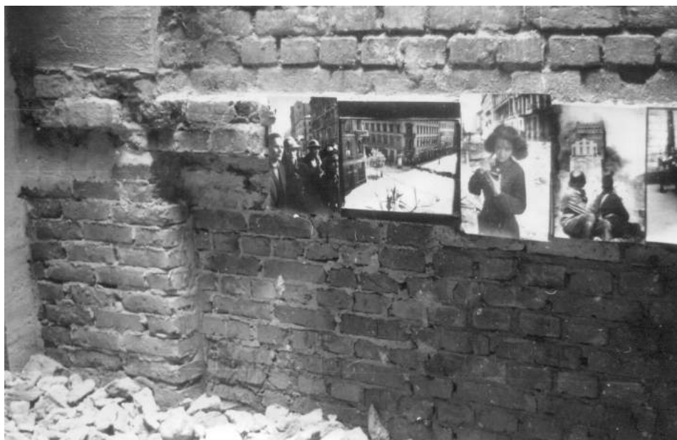
Varsó, fotókiállítás az épülő prímási palotában
