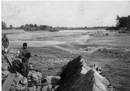
Az 1907-ben átszakadt betongát
