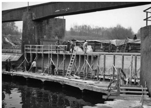
Az 1995. évi felújítás. A tömlős gát szerelése a bal parti nyílásban.
