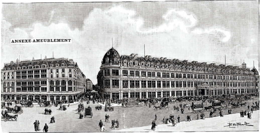
VUE des MAGASINS, RUE du BAC
