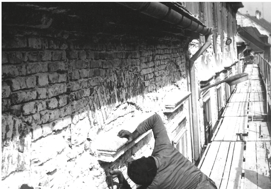
7. Sopron, Új utca 28., homlokzati falkutatás, 1975. © MÉM MDK, Tervtár, ltsz.: D 36333
