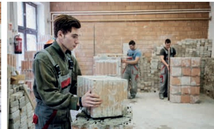
Téglából készítenek pillért a kőműves szakos diákok, már csak a vakolás van hátra.
