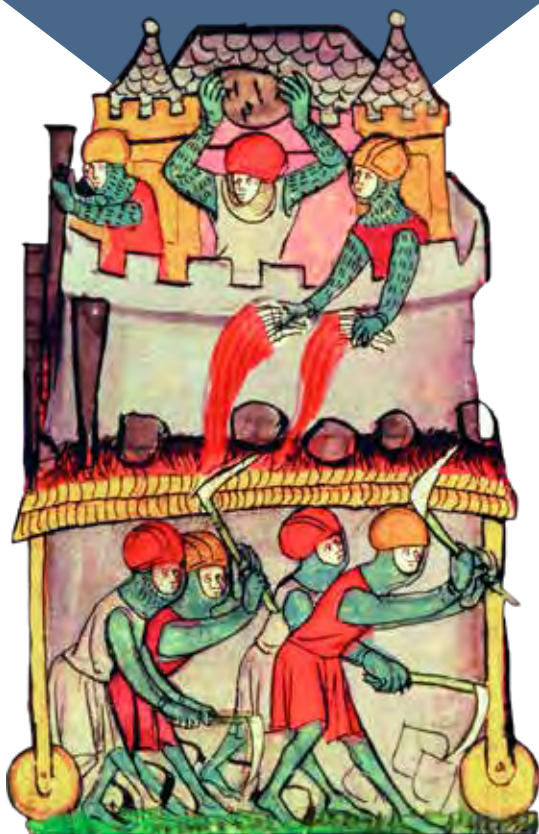
Árkászok falbontás közben, az illusztráción jól látszik, hogy a mozgatható védőfödém alatt egyhegyű csákányokkal dolgoznak
