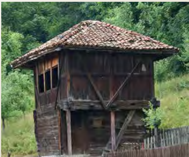
Újjáépített csardak (Burgau)
