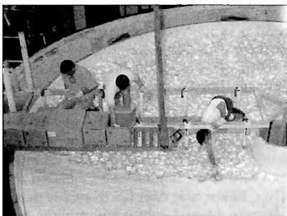
3. ábra. Az üvegtömbök elhelyezése
