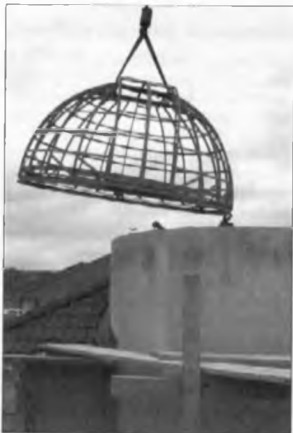
Az acélszerkezet darus beemelése
