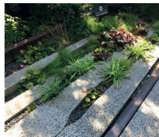
MEMENTŐ, ÁPOLT NÖVÉNYZETTEL A TERVEZŐ SZELLEMESEN ÁLLÍTOTT EMLÉKET A TERMÉSZET HŐDÍTÁSÁNAK A NÉHAI VASÚTI VIADUKTON
