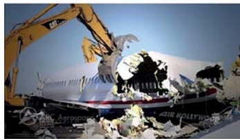
18. ábra. A forgalomból kivont repülőgép kompozitszerkezetei újrahasznosítás hiányában a hulladéklerakóba kerülnek
