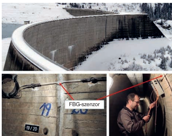
9. ábra. FBG-érzékelővel monitorozott gát Ausztriában
