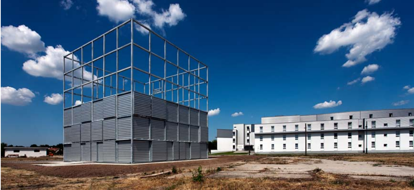
Az oldalanként 6x6-os acél-raszter alsó felén, egyenként 15 méter élhosszúságú kockákból épül fel a szerkezet
