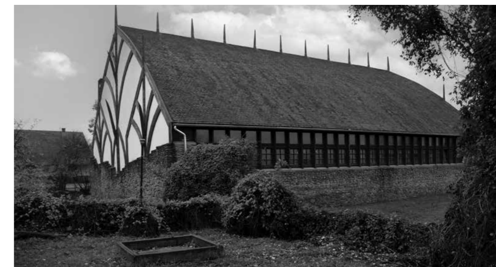
▲ Felújítás előtti állapot
