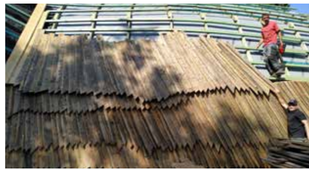
▲ Építés közben. Fotó: Faragó Melinda
