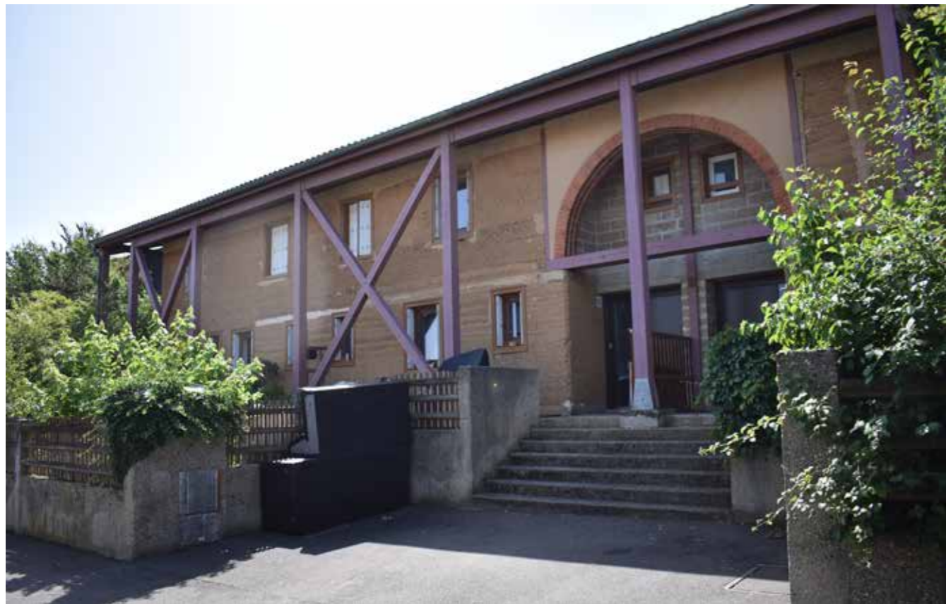
▲ A Domaine de la terre projekt név alatt készült vályogfal alapú városrész épületrészletei
