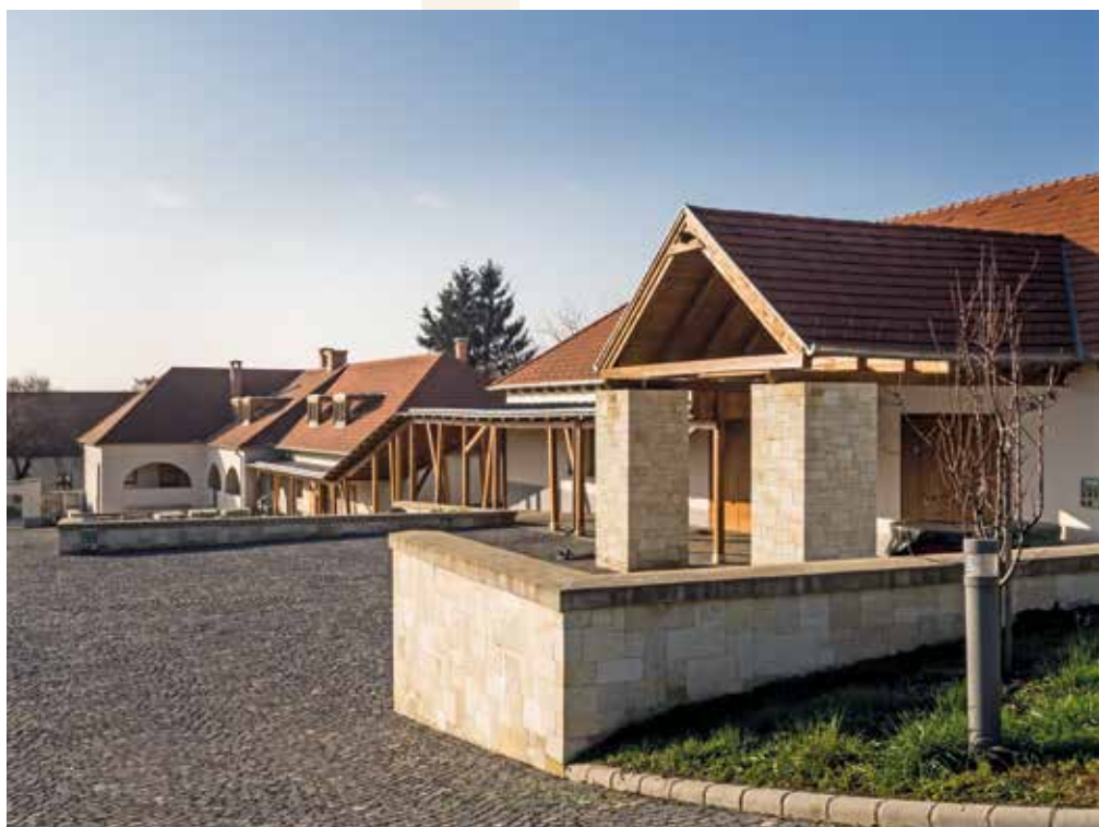
▲ Borászat, Tarcál. Építész: Salamin Ferenc, 2012
