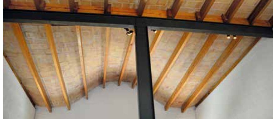
◀ Gaudí áthelyezett és felújított dolgozószobája, téglafödém részlet
