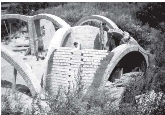
Gömbkupolás lakóház építés közben - Tököl
