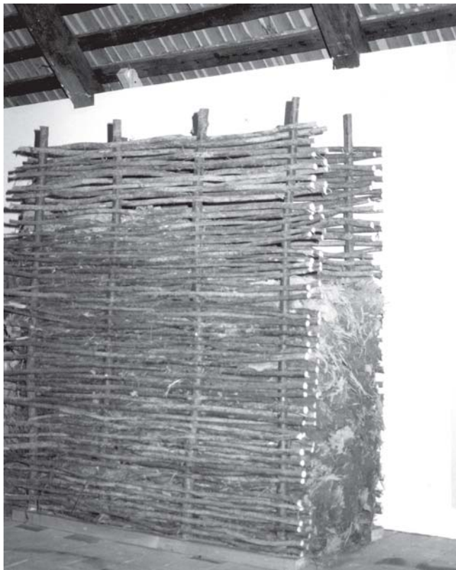
Vesszőfonat közötti sárfal kiállítási bemutatása
