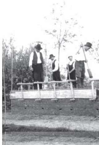
Vert vályogfal készítése kalodában
