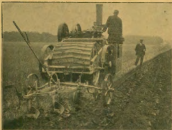
56. ábra. A Parmiter-féle gazdasági lokomotív mely szántásnál.
