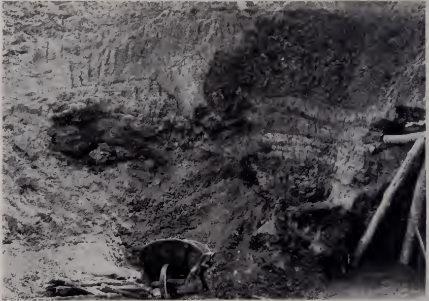
19. ábra. Az eplényi mangánérbánya fényképe. 1931. Mangánérees tarkaagyagok kaotikus gyűródése.
