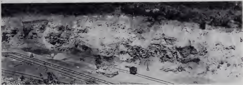
18. ábra. Az eplényi mangánérbánya külfejtése az 1938. évben. (Fénykép) A beírt betűk magyarázata: a = alsó liász kori mészkő; m = barrémiai kori mangánére és tarkaagyag; K = középső liász kori mészkő; f = felső liász kori mészkő; b = áttolódástól keletkezett breccsia. Az áttolódási sík az m és K réteg között van.
