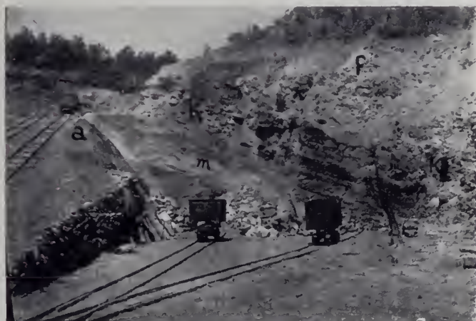
21. ábra. Az eplényi mangánércbánya külfejtésének fényképe az 1938. évben. Betűmagyarázat: a = alsó liászkeri mészkő; m = barrémiai mangánérces tarkaagyag; K = középső liász; F = felső liász; x = Ichthyosaurus csigolyák lelőhelye.
