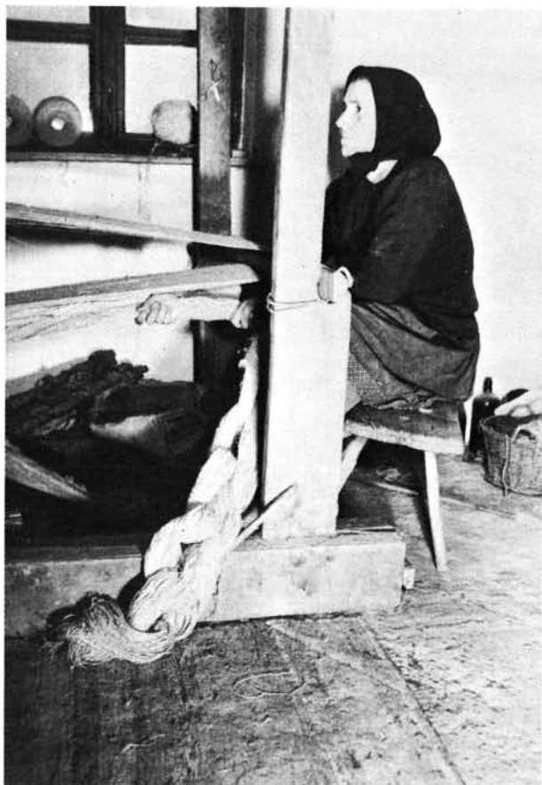
5. kép: A láncba leszedett fonalat feltekerik a szövőszékre.
