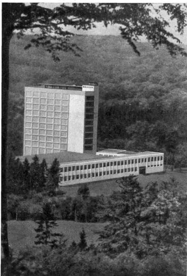
9. ábra. Saarbrücken. Egyetemi Könyvtár. Az épület keleti szárnyában 750 000 kötet befogadására emelt raktártoronyal
