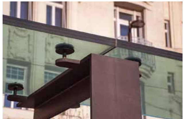
Üvegházhatású, háromrétegű üvegtető a 2-es villamos megállójában a Kossuth téren, Budapest V. Tervező: Középülettervező Zrt. (KÖZTI). Kivitelező: KÉSZ Építő Zrt., 2012–2014 Three-layer glass canopy producing a greenhouse effect in the stop of tram no. 2, Kossuth tér, Budapest V. Designer: Középülettervező Zrt. (KÖZTI). Producer: KÉSZ Építő Zrt., 2012–2014 Fotó: Zimmermann Eliza Hanna
