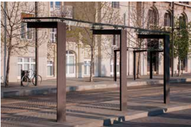
Elegánsan szellős, de kínosan kényelmetlen megálló a 2-es villamos vonalán, a Kossuth téren, Budapest V. Tervező: Középülettervező Zrt. (KÖZTI). Kivitelező: KÉSZ Építő Zrt., 2012–2014 Elegantly airy but awkwardly uncomfortable passenger shelter along the route of tram no. 2, Kossuth tér, Budapest V. Designer: Középülettervező Zrt. (KÖZTI). Producer: KÉSZ Építő Zrt., 2012–2014 Fotó: Zimmermann Eliza Hanna
