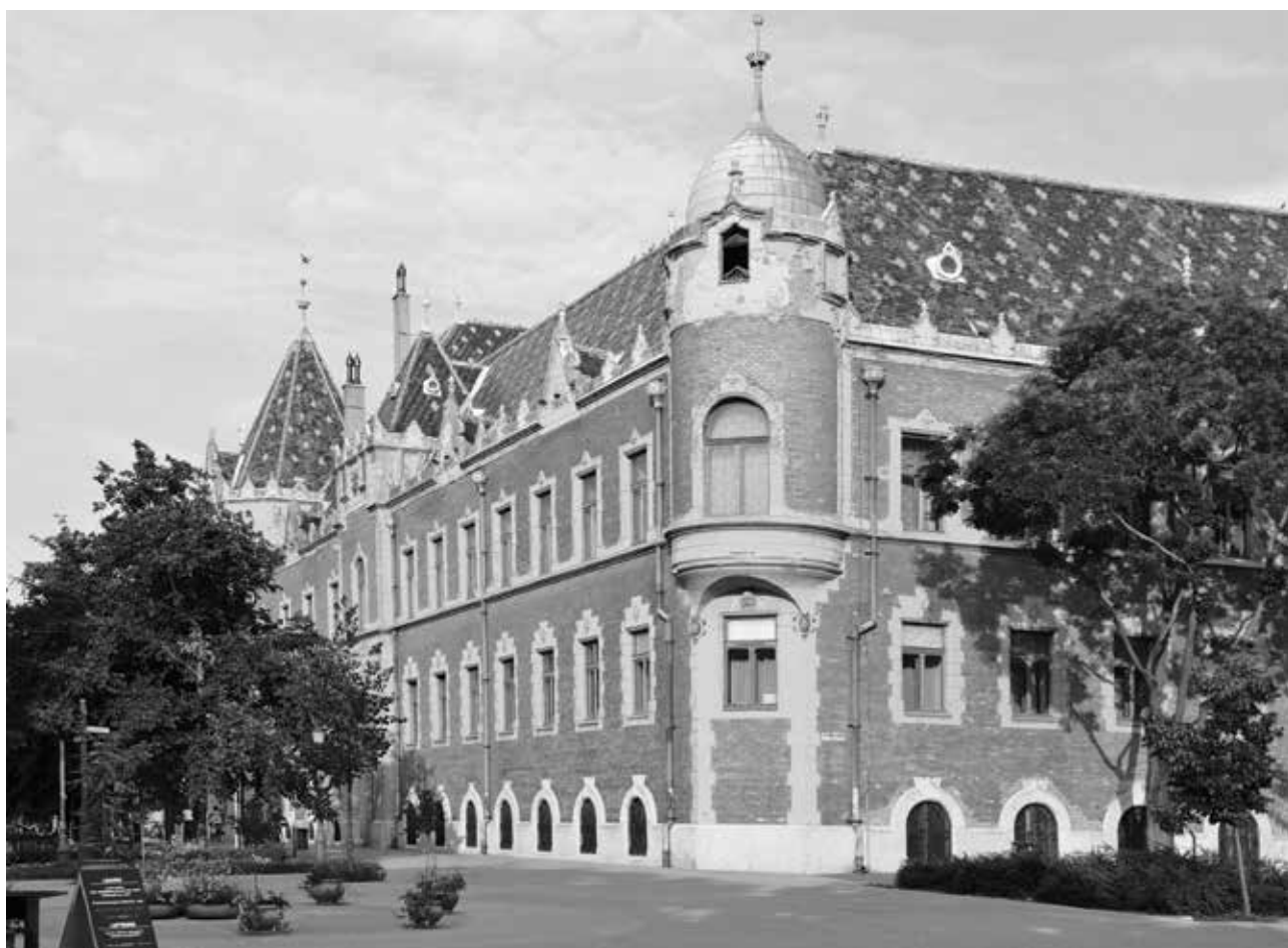
A kecskeméti városháza bal oldali sarkának lekerekítése | Chamfering of the left corner of the Kecskemét townhall
