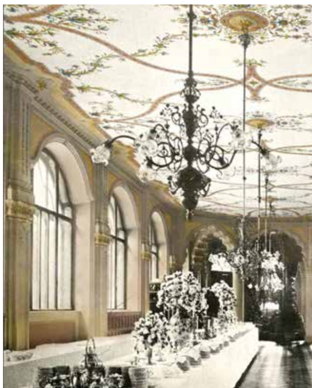
Vikár és Lukács Építész Stúdió: Díszítőfestés-rekonstrukció a galériatérben – munkaközi állapot
