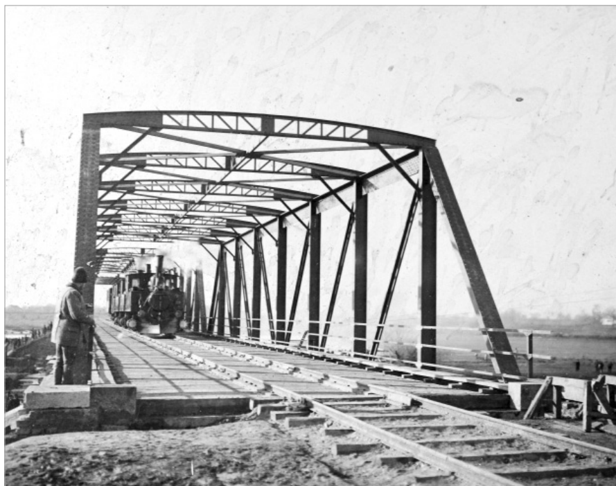
Az Ó-Bega feletti első vashidat Udvarnoknál 1898. október 19-én adták át a közúti és a vasúti forgalomnak
