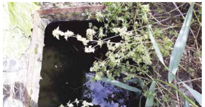
Használaton kívüli kút lezáratlan aknája település határában, a termőföldön (a szerző saját felvétele, 2019)
