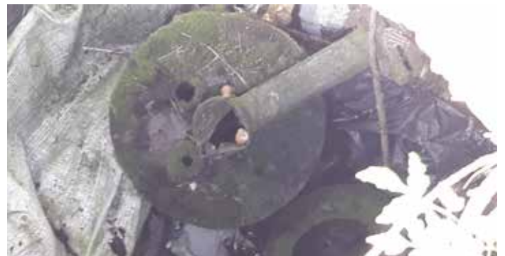
Nem teljes mértékben zárt kútfej, a kútaknában pedig oda nem illő anyagok találhatóak (a szerző saját felvétele, 2019)
