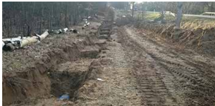
A dejtári vezeték példás előkészítése a nyomáspróbaához
