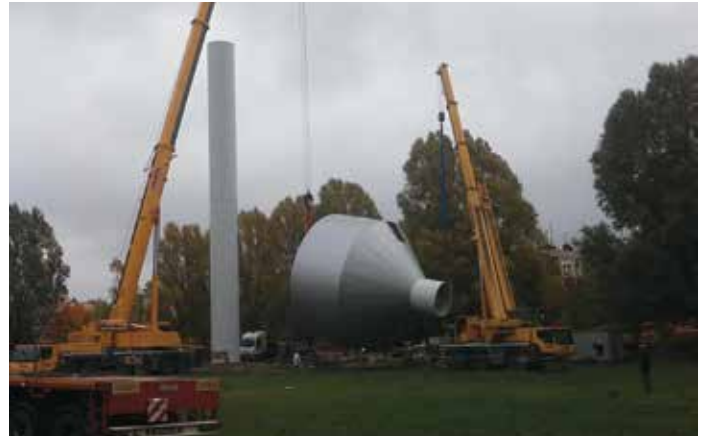
Az épülő kiskunhalasi, 500 m 3 -es víztorony
