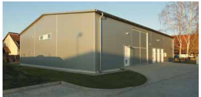
Kecel, vízműtelepi gépház
