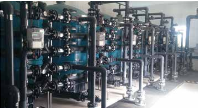
A jánoshalmi víztisztító technológia szűrőtartályai
