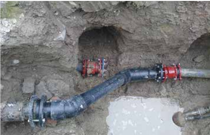
Hálózatrekonstrukció (átkötések idejére két nyomóvezeték párhuzamosan)
