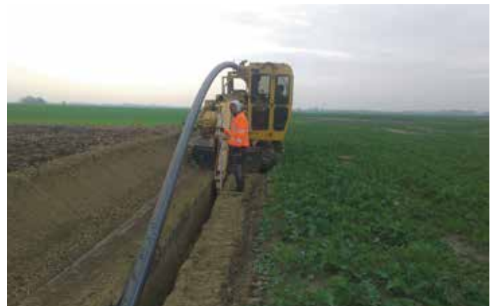
Épülő Dk160 KPE távvezeték
