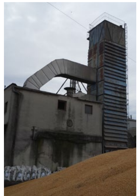
1. ábra. A tüzelőberendezés zárt épületbe történő elhelyezése (Forrás: saját felvétel)
