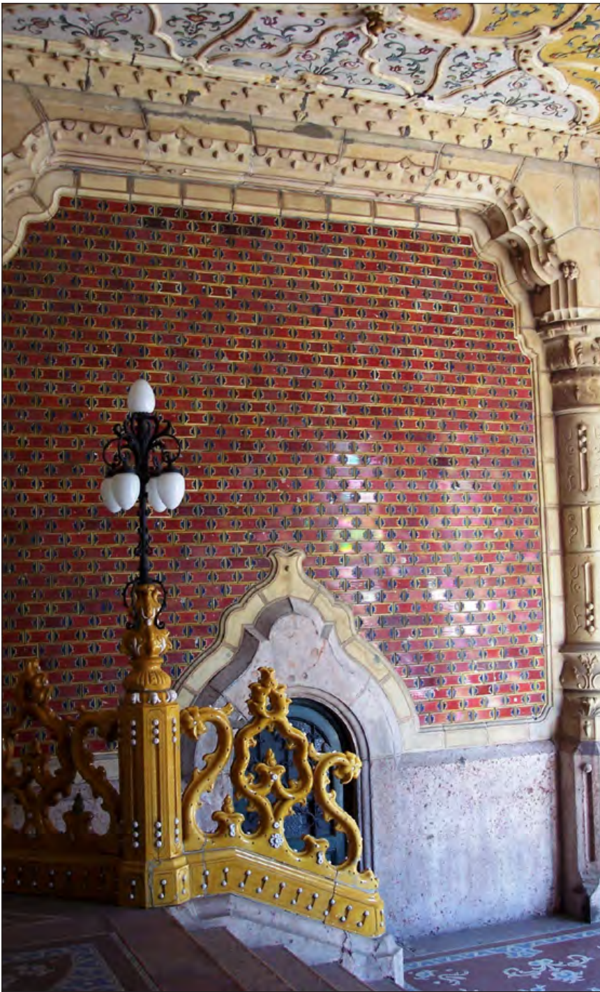
Az Iparművészeti Múzeum veszti büljét Zsolnay pirogránit pillérrel és a lüszteres mázas téglaburkolattal, a mennyezet népi motívumokból formált mázas pirogránit díszítményeivel
