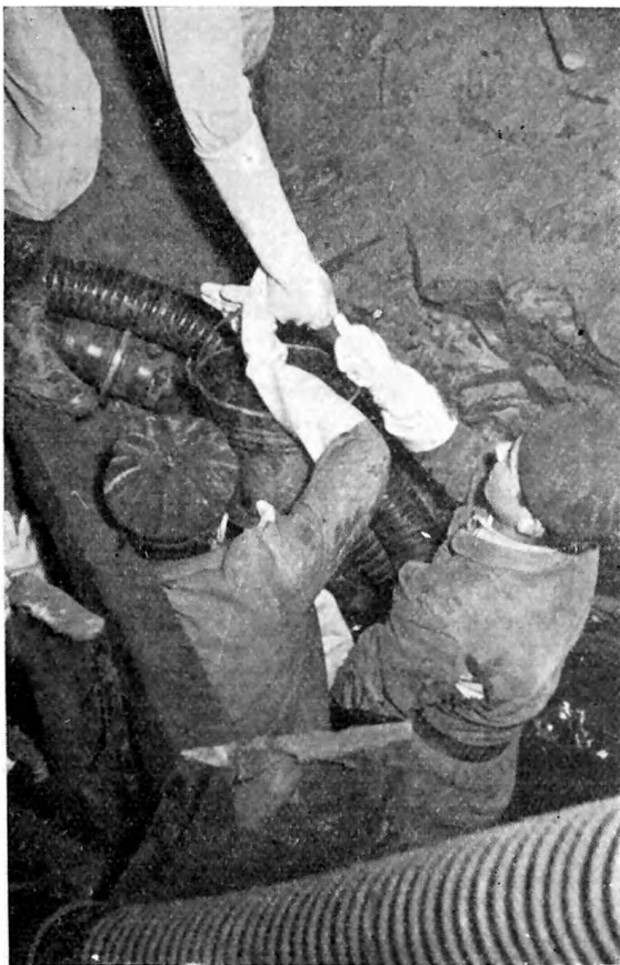
Szifonban levő törmelék kitermelése szivattyúk védelme mellett
