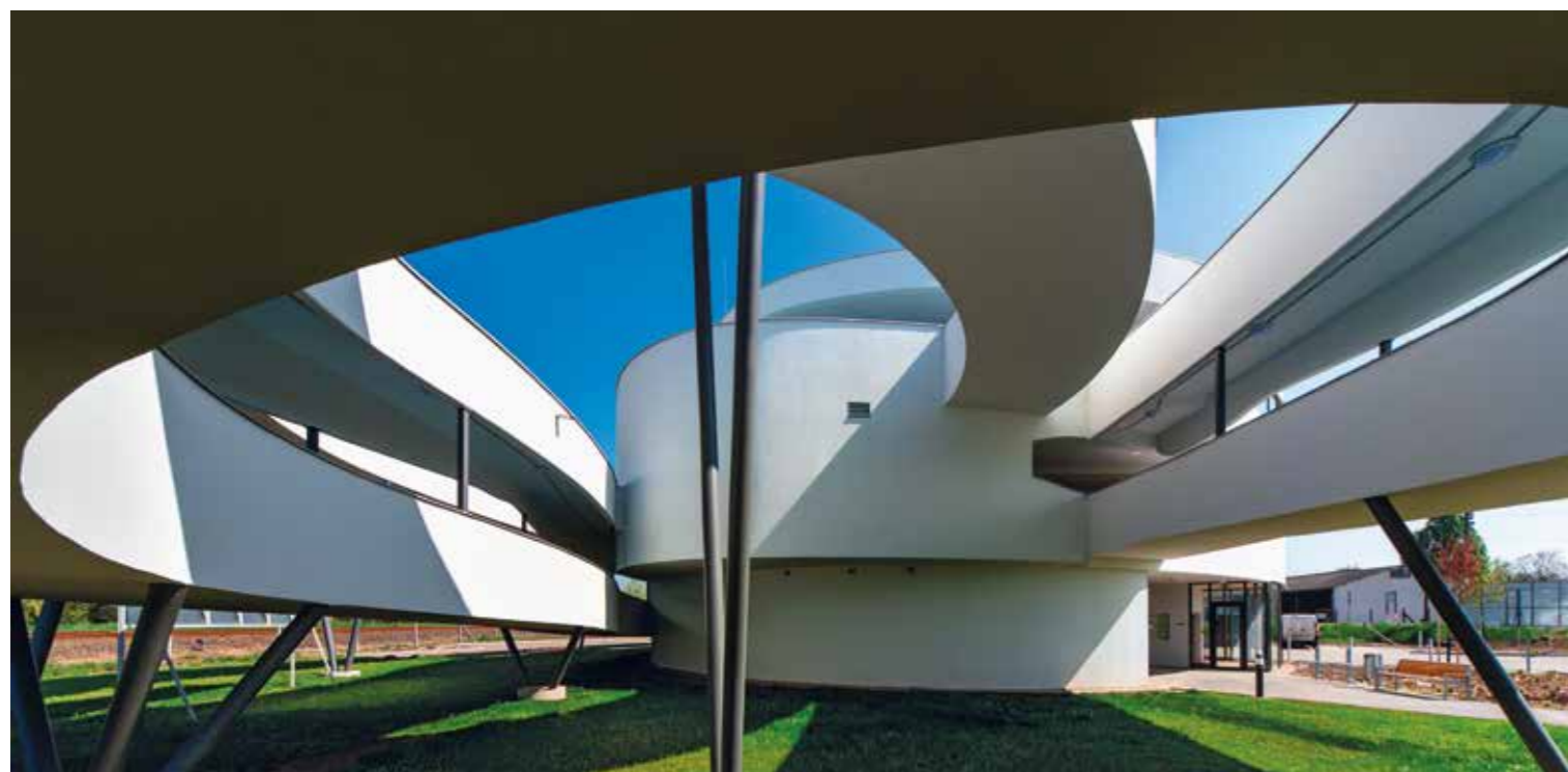
▲ Hullámzó, örvénylő látványt mutatnak a közlekedőspirálok a Tisza-tó felőli oldalról
